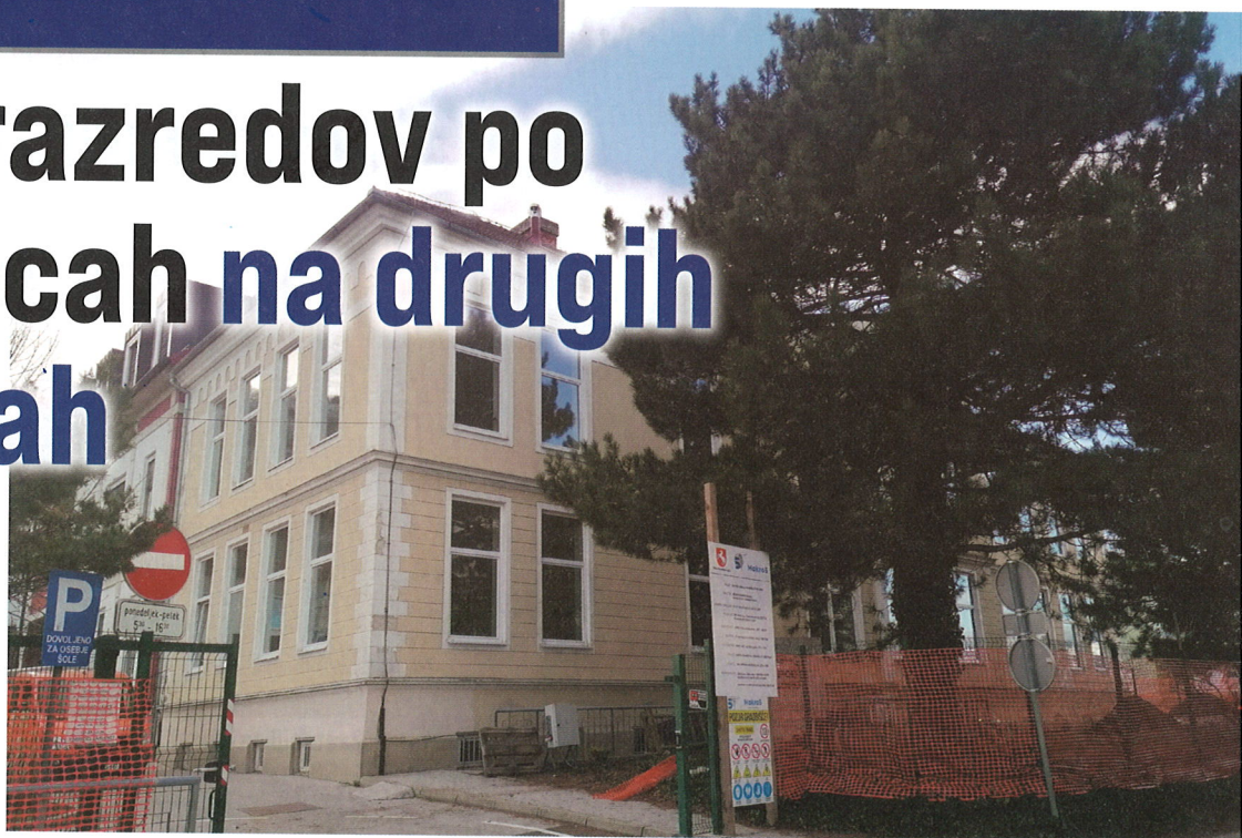
Gradbišče za začetek obnove najstarejšega dela šole že pripravljajo.
